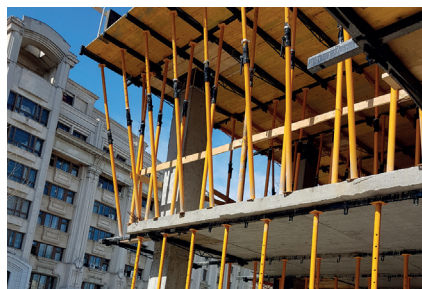
Poutre longitudinale parallèle au rive de dalle
