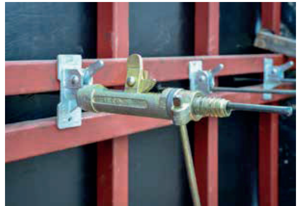
Tige de coffrage & écrou articulé serti sur plaque
